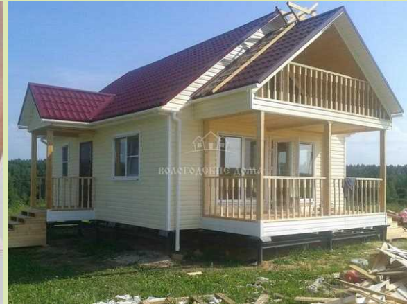
Строительство домов из бруса. Каркасный дом под ключ
